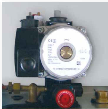
Motore pompa con disareatore incorporato
